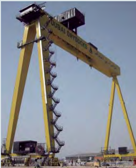
Double girder construction 300 t / 70 m, U.A.E.
